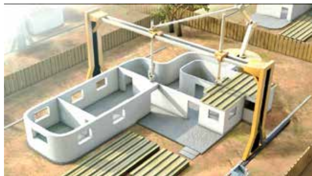
Рис. 8. Будівля роботизованих систем будівництва
