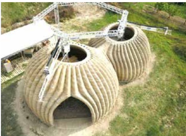
Рис. 4. Створений будинок круглої форми роботом-3D-принтером
