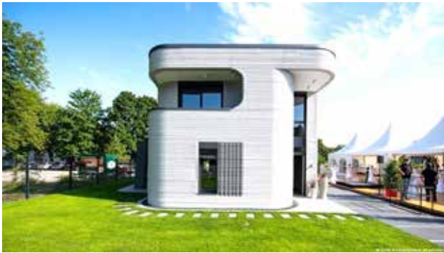
Рис. 9. Побудований будинок роботом-3D-принтером
